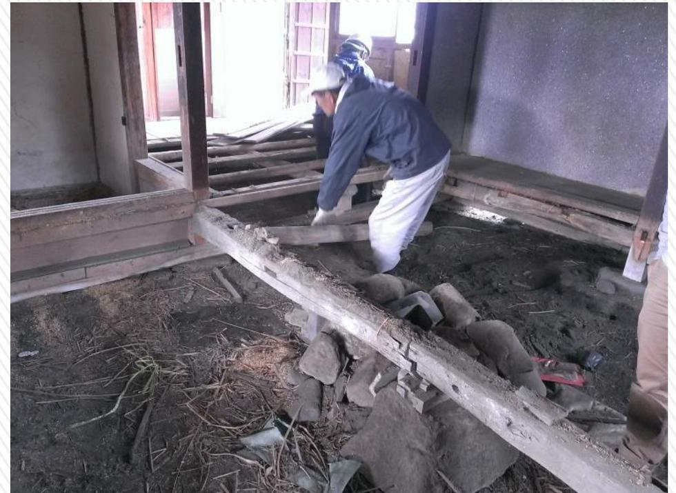
床板をはがすと、床下も同じく石の上に柱が据えてあるだけ！
